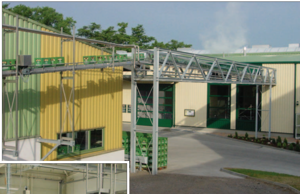
Leergebindetransport vom Leergutlager via Brücke über den Hof in den neuen Flaschenkeller.
