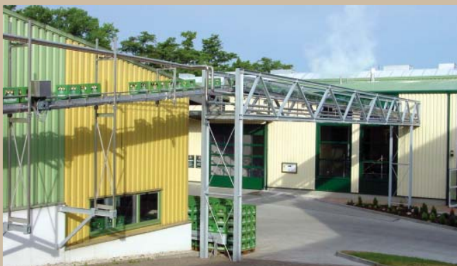
Abb. 1 Leergebindetransport vom Leergutlager via Brücke über den Brauereihof in den neuen Flaschenkeller
