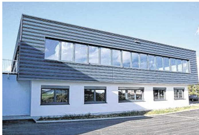
Neues Büro-Gebäude in der Ferdinand-Porsche-Straße 5 in Ellwangen.
